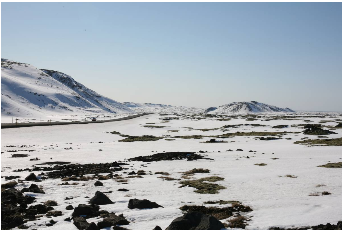
Mynd 4.6 Horft til suðurs frá veðurathugunarstöð Vegagerðarinnar við Þrengslaveg. Sjá má Þrengslaveg (t.v.), Litla-Sandfell fyrir miðri mynd og í hluta Geitafells (t.h).
